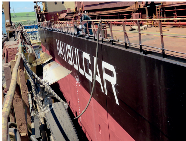
5 юни 2015 г. М/к „Миджур“, доков ремонт в ККЗ на МТГ „Делфин“.
